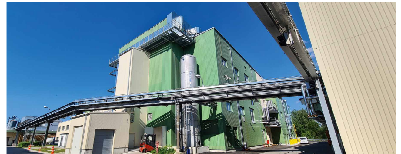
Außenansicht der neuen Extraktionsanlage
